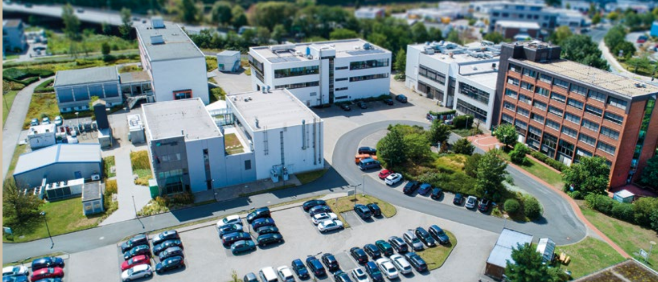
Gebäudekomplex Fraunhofer UMSICHT, Foto: Fraunhofer UMSICHT/laviate Luftaufnahmen
