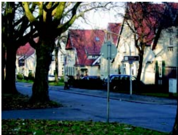
510 Wohneinheiten der Wohnsiedlung Teutoburgia werden künftig mit umweltfreundlicher Wärme versorgt
