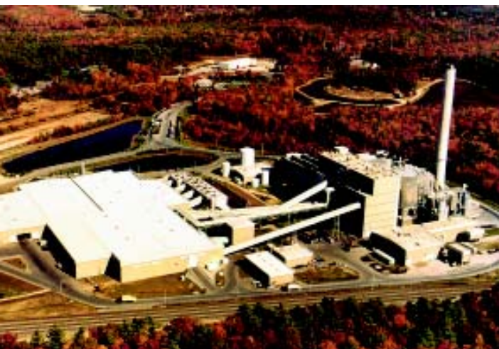
In der Vogelperspektive werden die beeindruckenden Dimensionen der SEMASS-Anlage besonders deutlich
