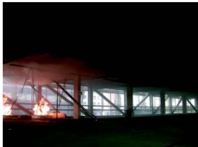
Entrauchungsüberprüfung in einem offenen Parkhaus
